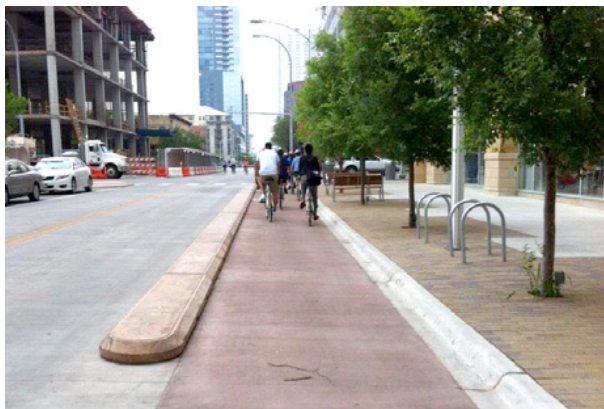
С приподнятым бетонным тротуаром
